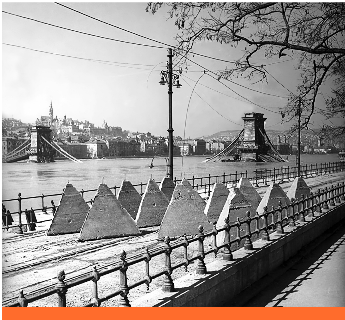
Akadály I. – Betonból öntött harckocsiakadályok a pesti Duna-parton, háttérben a felrobbantott Lánchíddal, 1945 (Fortepan)
